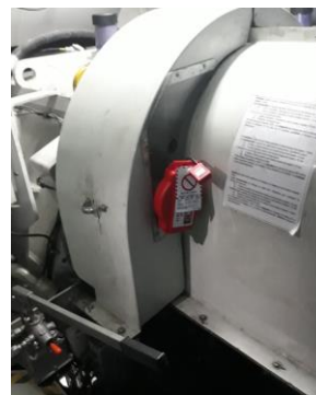
Instalación del sistema LOTO LOTO system installed
