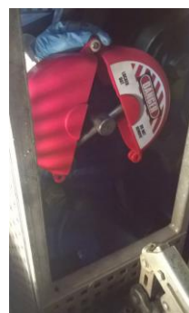
Instalación del sistema de consignación sobre la T de bloqueo Installation of the consignment system on the locking T
