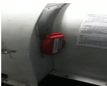
Instalación de la otra mitad del sistema de consignación sobre la T de bloqueo Complete installation of the locking system above T lock
