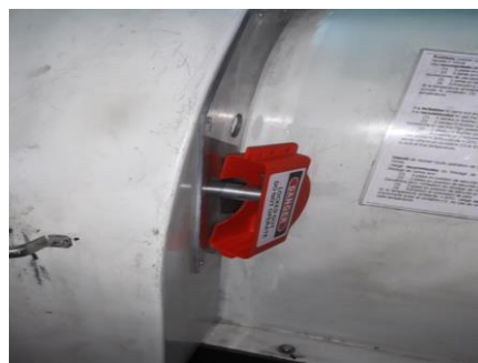
Instalación de la mitad del sistema de consignación. Installation of half of the locking system.
